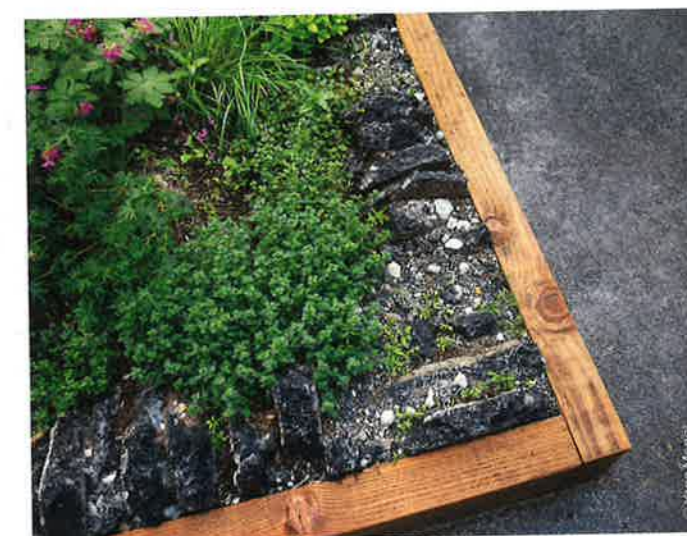
Mettre en scène Formant un rectangle de 18 m 2 , le jardin est cadré par des poutres en chêne. Elles s'imbriquent entre le substrat placé à l'intérieur et l'enrobé périphérique.
