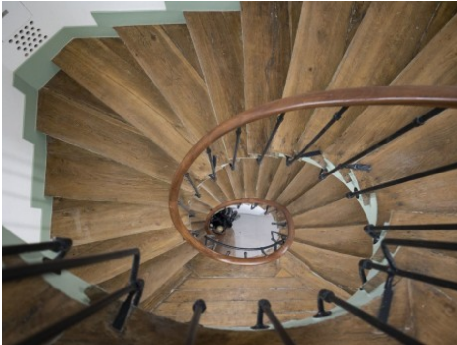
L'un des escaliers de l'immeuble 11 rue Bergère, dans le IXe arrondissement de Paris. © Sophie Loubaton
