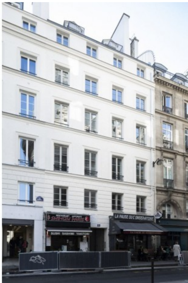
L'immeuble 11 rue Bergère côté rue. © Sophie Loubaton
