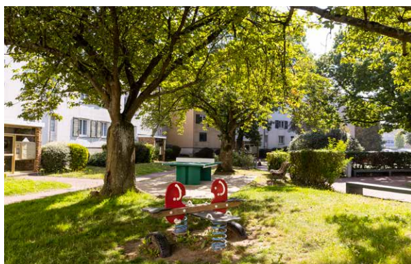
▲ Logements conventionnés du Domaine de Beauregard à La Celle Saint-Cloud.
